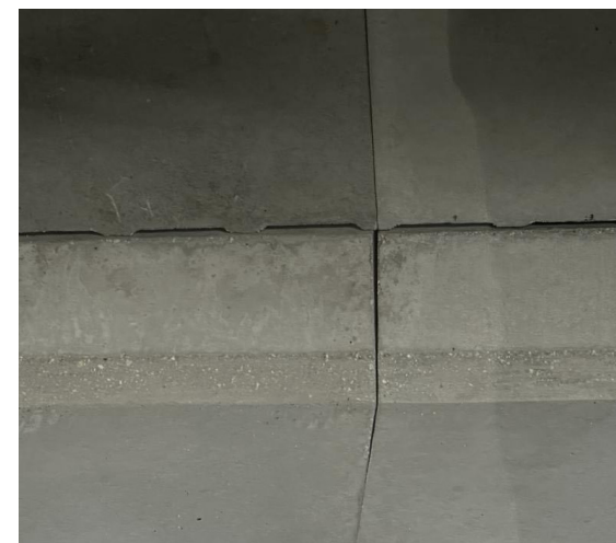
Interior refractory concrete Innenverkleidung Feuerfestbeton
